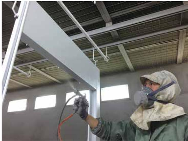
鋼製建具枠を塗装中
